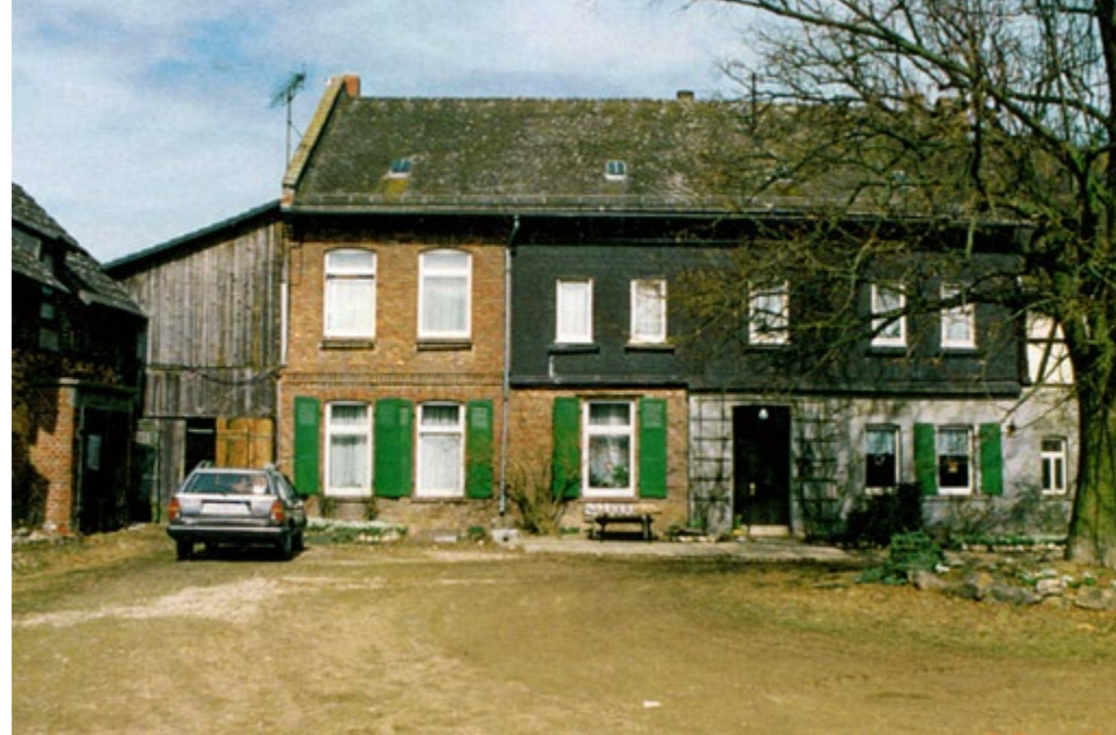
← Der Blick vom Hof auf das spätere Hotel-Restaurant Georgios.
